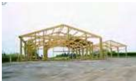
Photo 2 : Une charpente bois avant la couverture (crédit photo : Idele).
